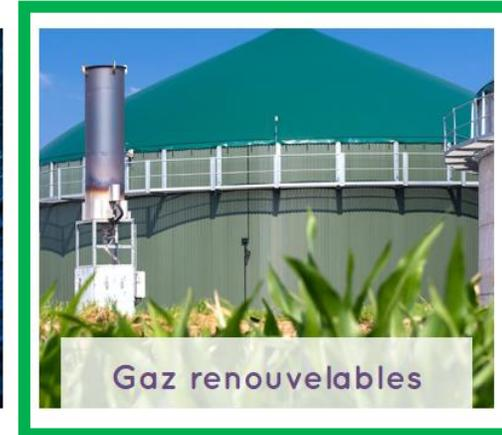
Les **gaz renouvelables** sont produits par différentes typologies d'installations : les installations de méthanisation de type agricole, industriel, déchets ménagers et biodéchets ou à partir de boues de stations d'épuration, les installations de stockage des déchets non dangereux, etc.
